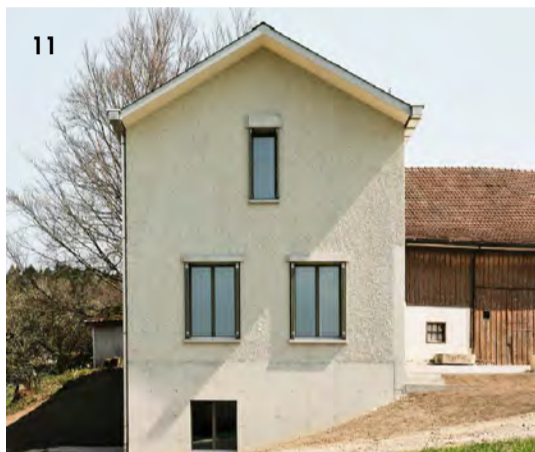
11 Einfamilienhaus Eidbergstrasse, Winterthur Architektur Büro Marazzi Reinhardt GmbH, privat
