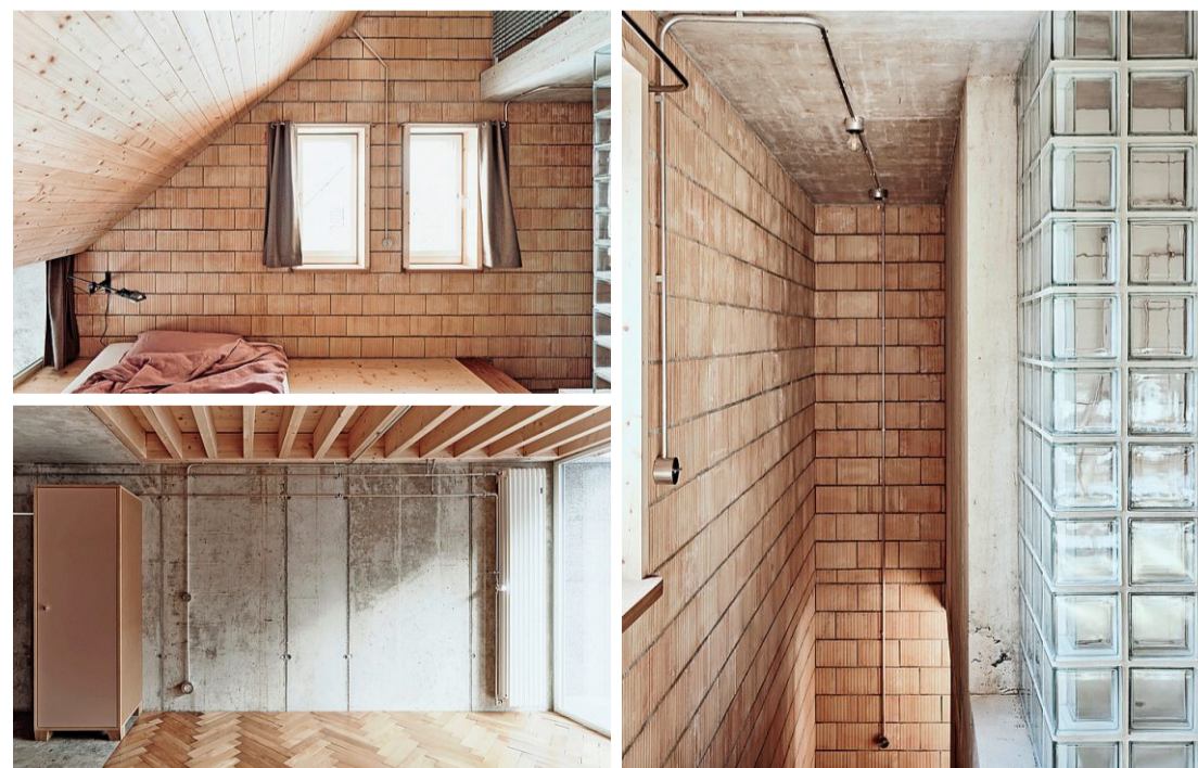
Die Innenräume: Die Qualität des Rohmaterials wird bewusst gezeigt; um Ressourcen zu sparen, wurden zudem gewisse Baumaterialien wie der Parkett aufbereitet und wieder eingesetzt
